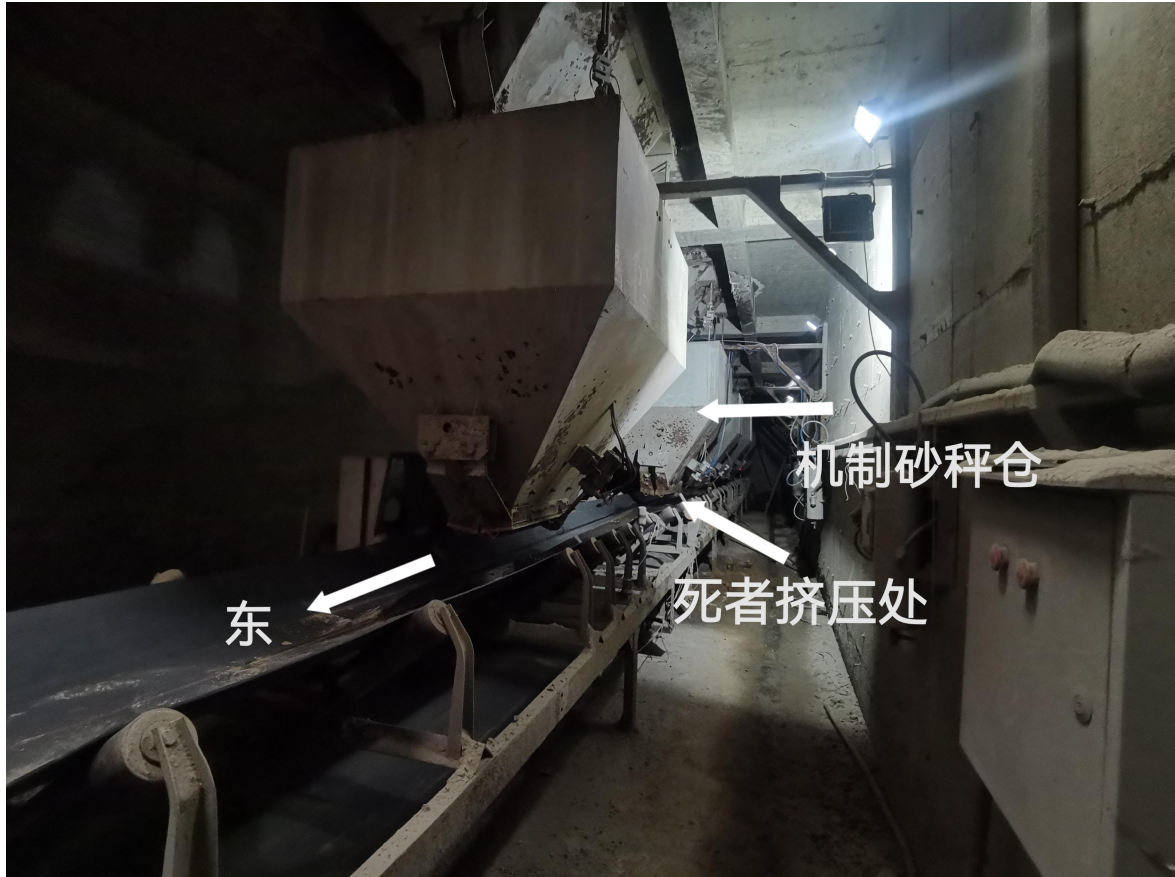
西机混凝土生产线骨料配料秤料地坑
